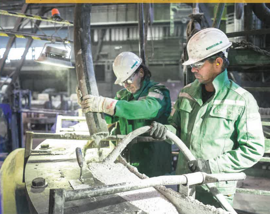
Mit verschiedensten technischen Hilfsmitteln und Schablonen sowie jahrelanger Erfahrung werden passgenaue Pfannenabschlüsse oder spezifische FF-Bauteile gegossen, verdichtet und getrocknet.
